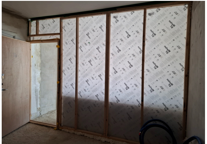
Vinduesåbningen til de nye vinduespartier er klar
