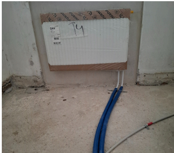
De nye varmerør føres i pexrør under gulvet
