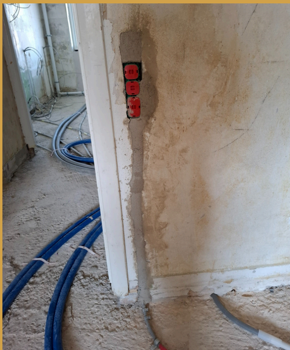
Der opsættes nye stikkontakter og elinstallationer i hele lejligheden
