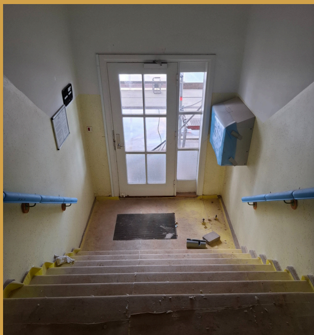
Der er lagt pap og plast på opgangene for at beskytte dem mod trafik med maskiner og materialer
