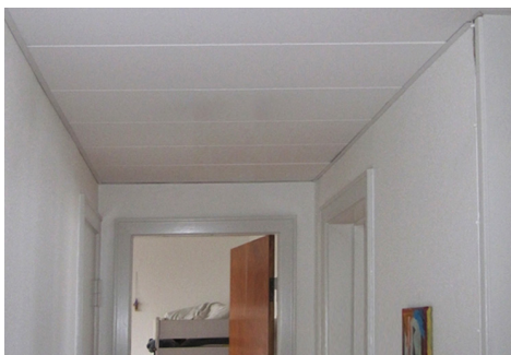
Eksempel på et nedhængt loft i gangen
