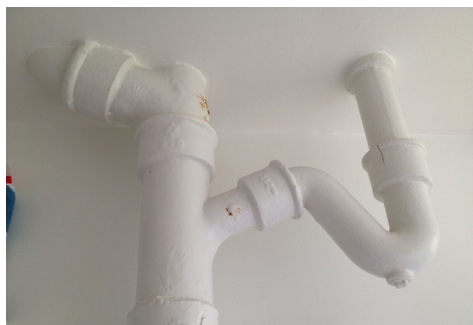
Eksempel på afløbsinstallationer som skal udskiftes
