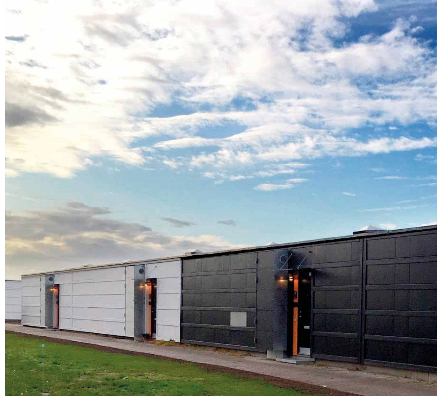
Nogle huse i AB Vest renoveres endnu, mens andre allerede står færdige. Disse huse er færdigrenoverede og beboede.
