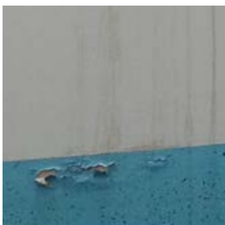
Maling skaller af vægge i opgang pga. vandindtrængen fra tagvinduer.
