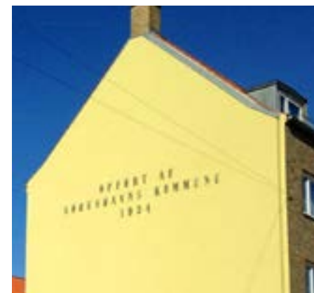
Eksempel på efterisoleret og oppudset gavl.
