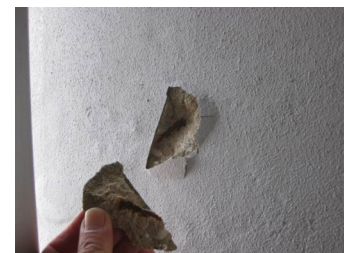
Armeringsskader
