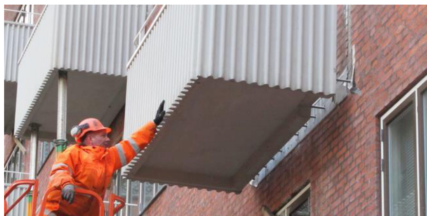
Med højstyrkebeton kan opnås en fin detaljering af altaner og altaner vil kunne udføres som færdige elementer fra fabrik.
