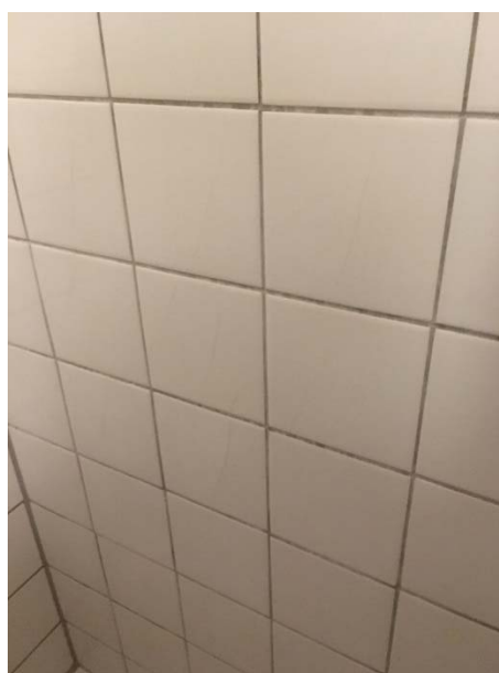
Foto 4 – revnedannelser, vertikalt
