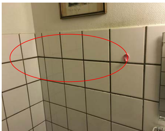
Foto 2 – vægfliser, udskiftet
