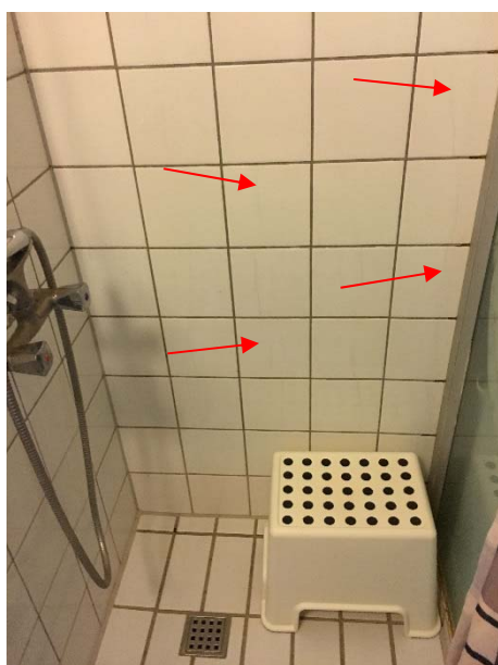
Foto 3 – revnedannelse, vertikalt
