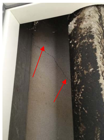
Foto 4 – revnedannelse, diagonalt
