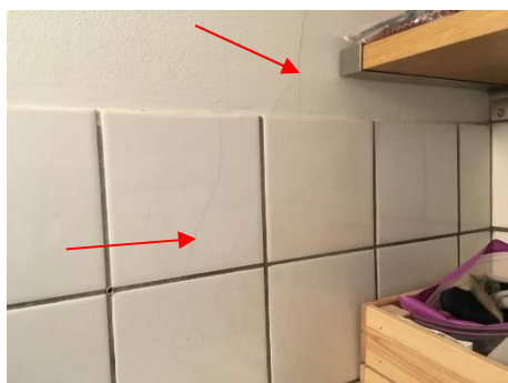
Foto 3 – revnedannelser, vertikalt
