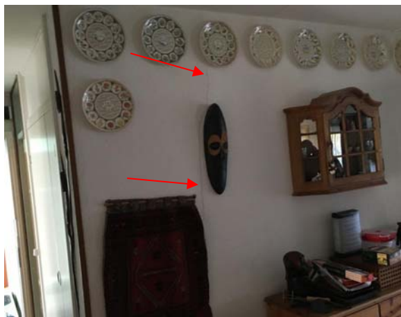
Foto 1 – revnedannelse, vertikalt
