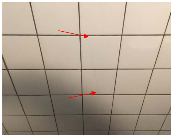
Foto 2 – revnedannelser, vertikalt
