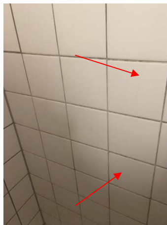
Foto 2 – revnedannelser, vertikalt
