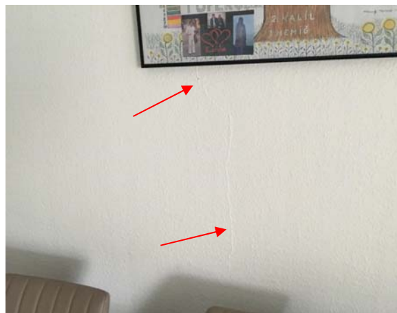
Foto 2 – revnedannelse, vertikalt
