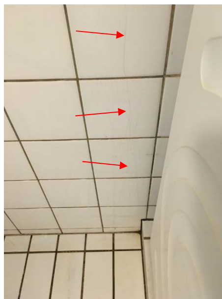
Foto 4 – revnedannelser, vertikalt
