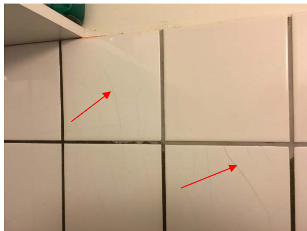
Foto 2 – revnedannelse, diagonalt
