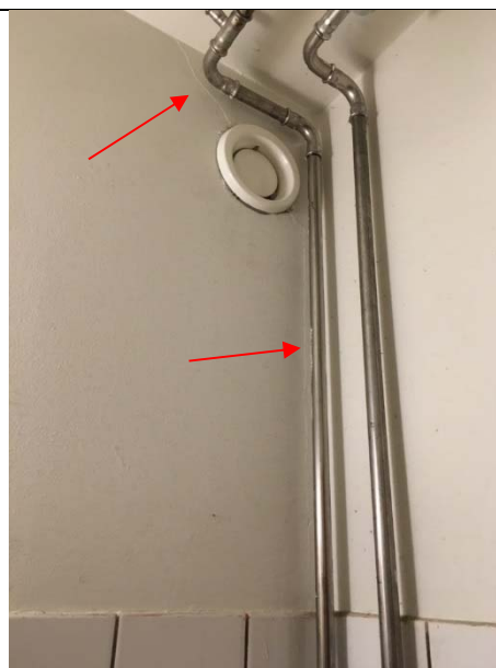
Foto 4 – revnedannelse, vertikalt
