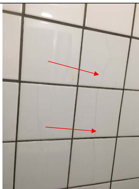
Foto 4 – revnedannelse, vertikalt
