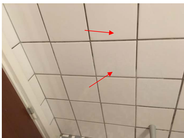
Foto 3 – revnedannelser vertikalt
