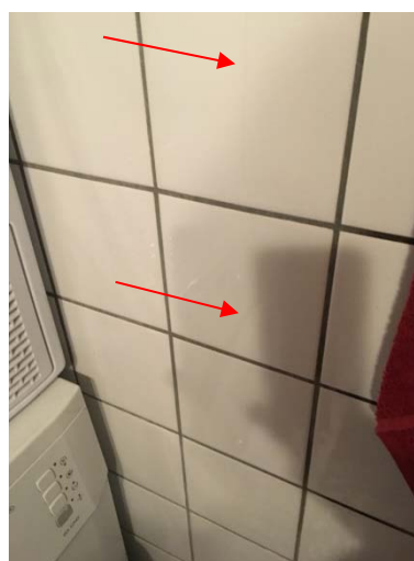
Foto 4 – revnedannelse, vertikalt
