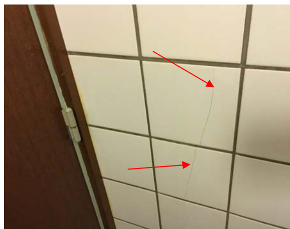
Foto 3 – revnedannelse, vertikalt
