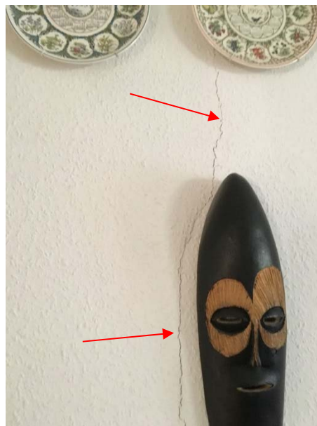
Foto 2 – revnedannelse, vertikalt
