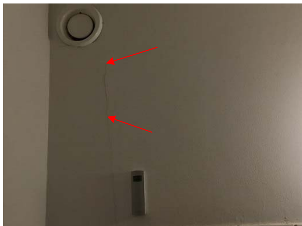
Foto 1 – revnedannelser, vertikalt
