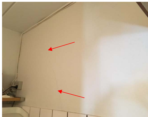
Foto 2 – revnedannelser, vertikalt
