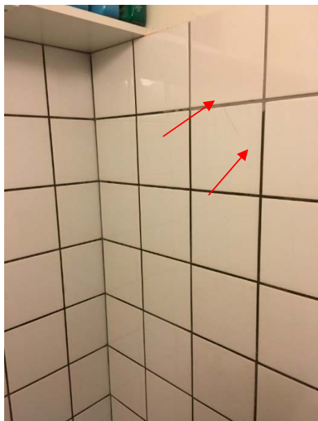
Foto 1 – revnedannelse, diagonalt
